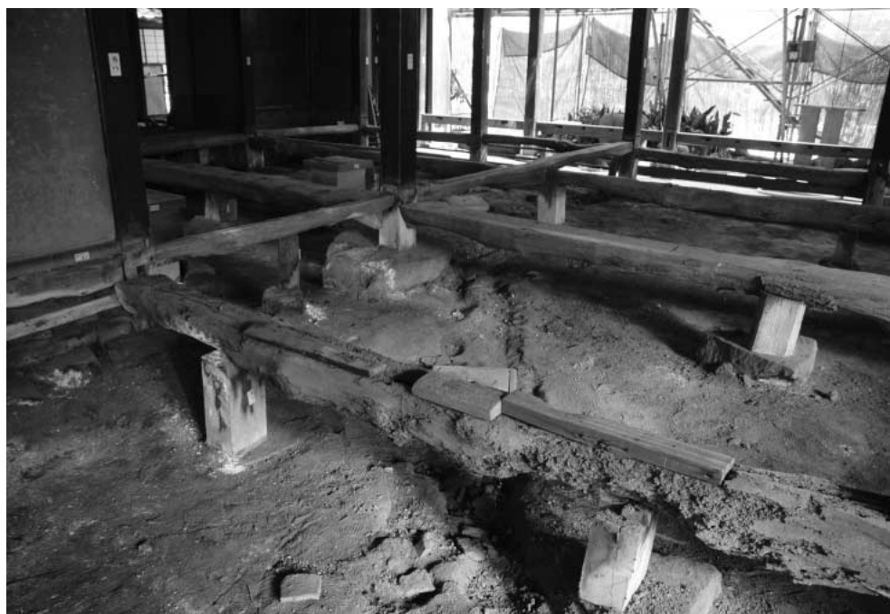
a 調査前状況
