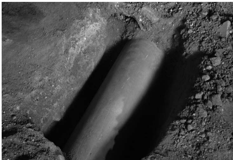
b 排水管検出状況
