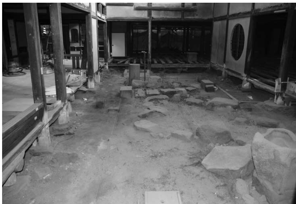
a 調査前状況
